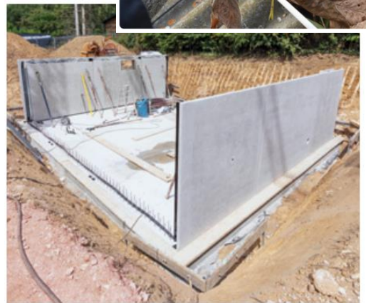
Keller in WU-Bauweise
