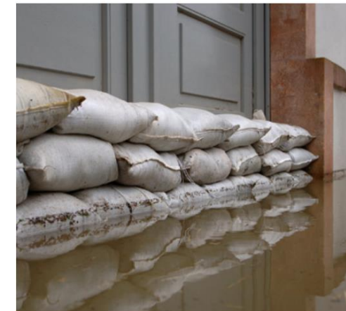
Notfallmäßiger Objektschutz mit Sandsäcken
