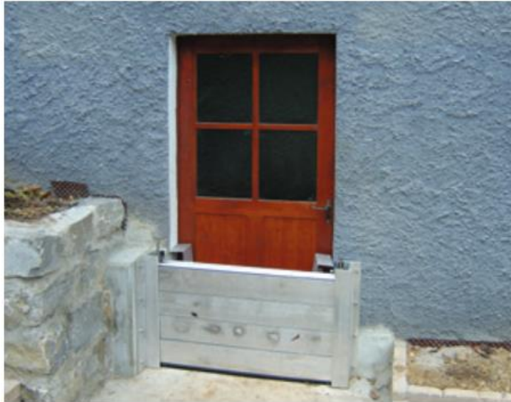
Objektschutz an Gebäudeöffnungen
