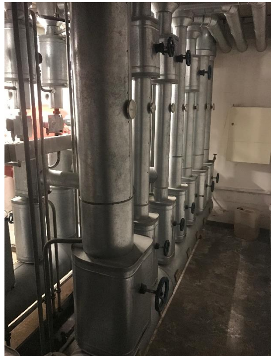
Hauptrücklaufverteiler
