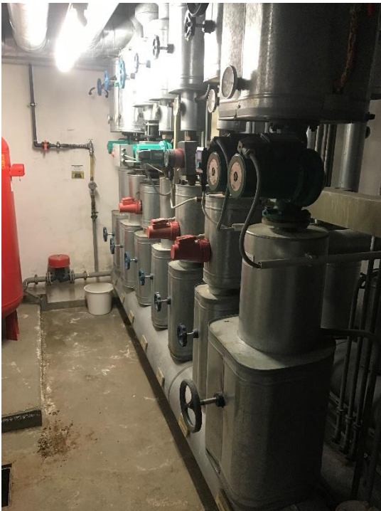
Hauptvorlaufverteiler
