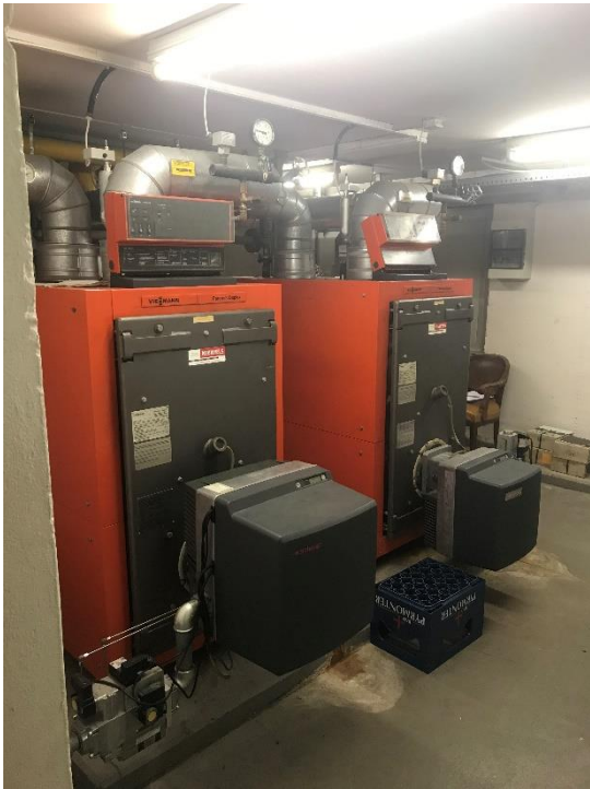
Gas-Niedertemperaturkessel 1 & 2
