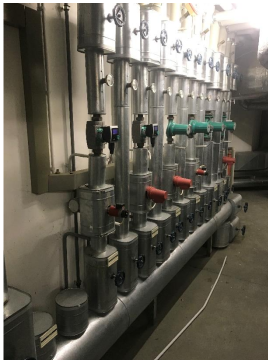
Unterverteiler Lüftungszentrale
