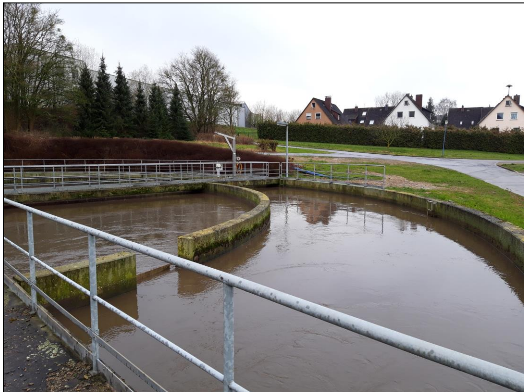
Abbildung 2-4: Belebungsbecken 1/2 GKW Bad Pyrmont-Lügde
