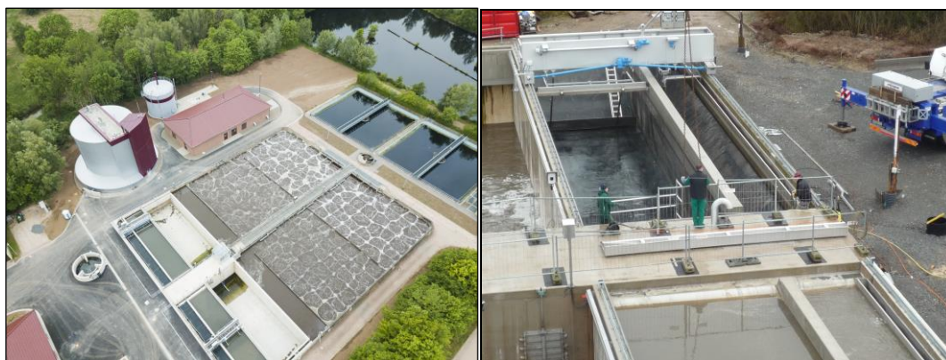
Abbildung 4-2: Kombiniertes Sandfang und Vorklärbecken
