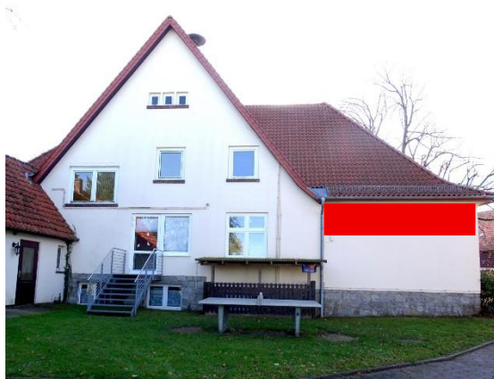
Abb. 7 Nordfassade des Kindergartengebäudes (Hofseite)
