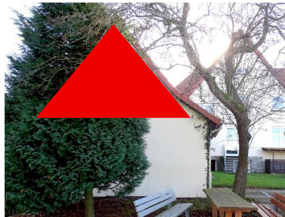
Abb. 8 Nordseite der Garage (Anbau des Kindergartengebäudes)
