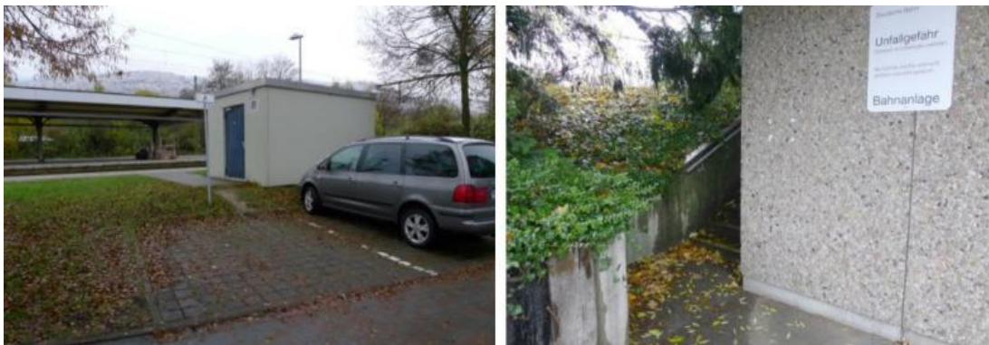
Abb. 16 Zugang zu Gleis 1 von der südlichen P+R-Anlage (li.) und Zugang zu Gleis 1 (Treppe) nördlich am Bahnhofsgebäude, für Unbefugte verboten (re.)
