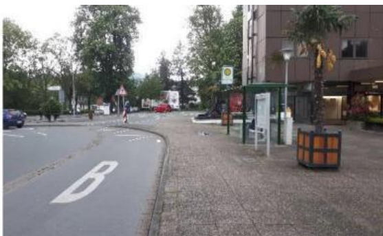
Abb. 12 Bussteig B (li.); fehlender Bussonderbord, fehlendes Blindenleitsystem etc. am Bussteig A (re.)
