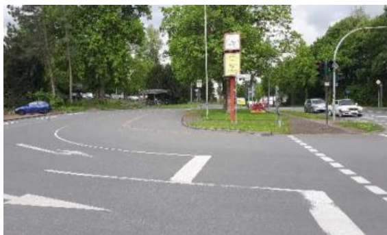
Abb. 12 Bussteig B (li.); fehlender Bussonderbord, fehlendes Blindenleitsystem etc. am Bussteig A (re.)
