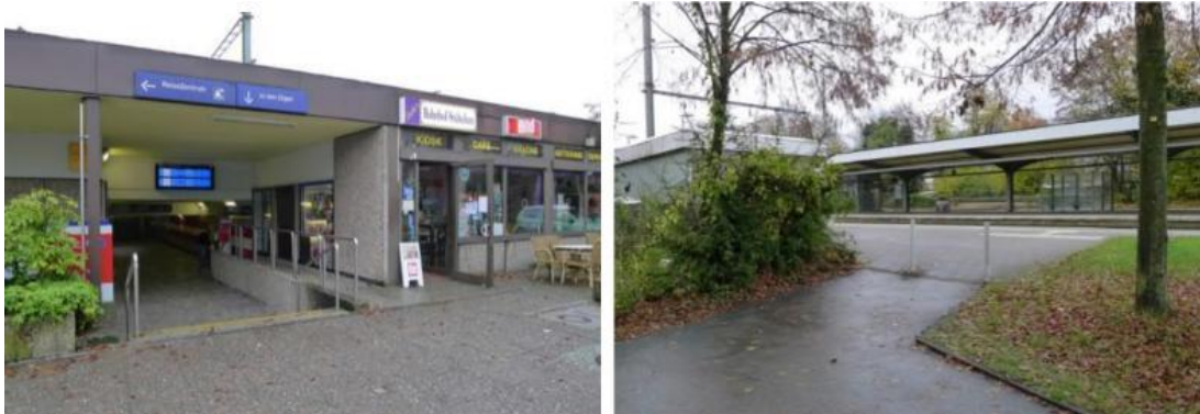
Abb. 15 Gleiszugang über eine Treppe vom Bahnhofsvorplatz (Rampe parallel zum Gebäude; li.) und Zugang zu Gleis 1 von der südlichen P+R-Anlage (re.)
