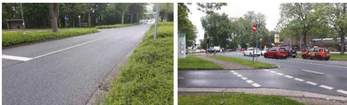
Abb. 24 Blick in die Bahnhofstraße (li.) und Einmündung des Bypasses mit Blick auf den Knotenpunkt der Landesstraßen (re.)
