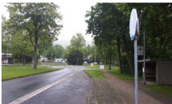
Abb. 12 Bussteig B (li.); fehlender Bussonderbord, fehlendes Blindenleitsystem etc. am Bussteig A (re.)
