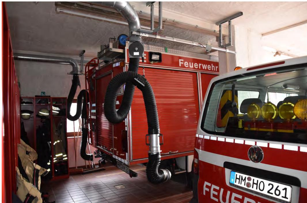
Abb. 7.3-9: OF Holzhausen: PSA und Abgasabsauganlage im Erdgeschoss
