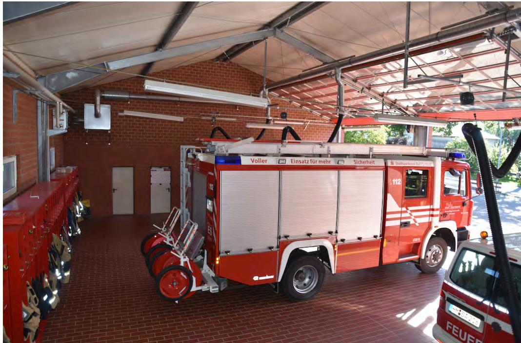
Abb. 7.3-35: Baarsen: Fahrzeughalle mit Abgasabsauganlage
