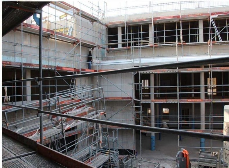
Der Schulneubau wächst in die Höhe, die Kostenobergrenze auch.
