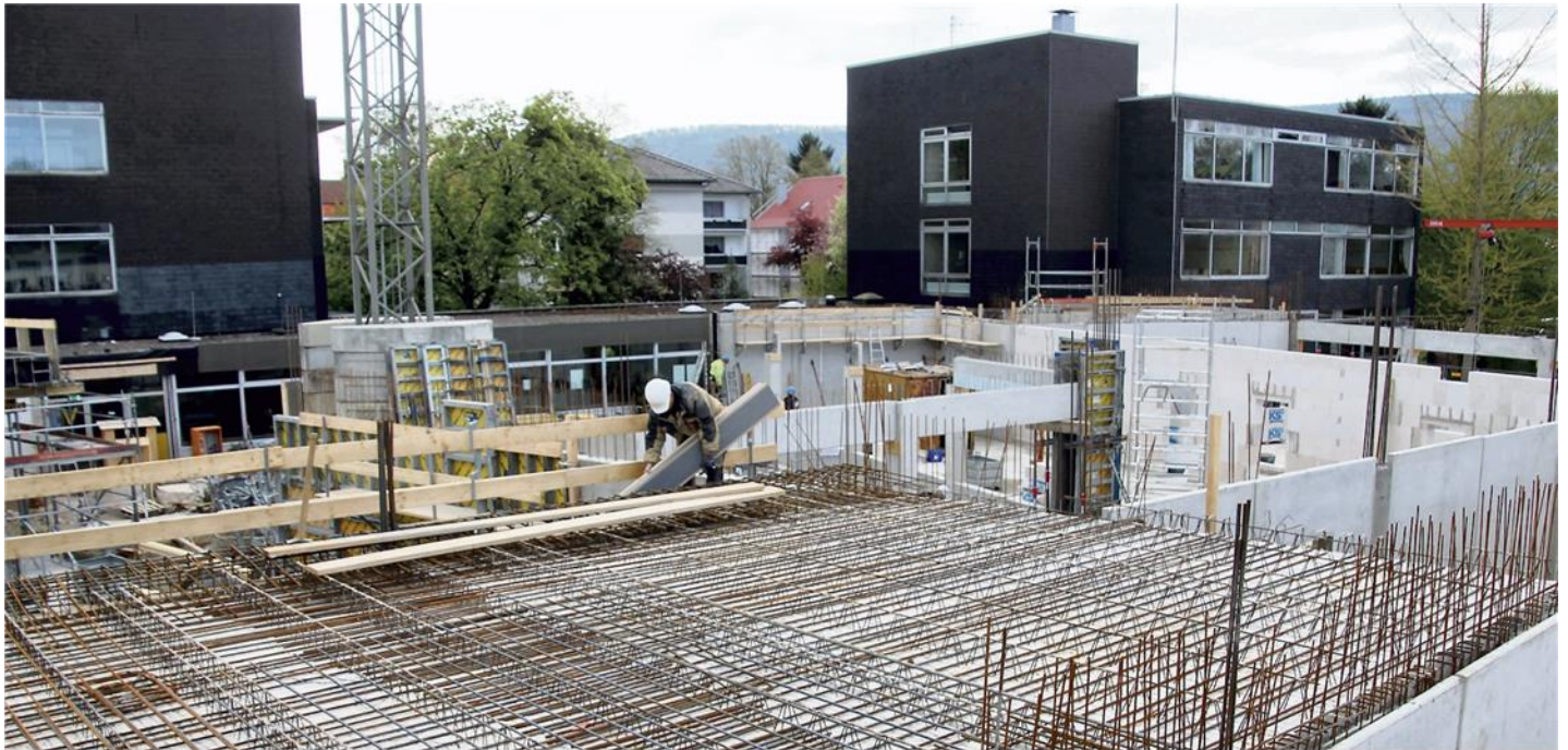
Der Neubau des Humboldt-Gymnasiums kommt gut voran: In einem Gutteil des Erdgeschoss-Rohbaus ist schon die Decke eingezogen. Laut Projektleiter Josef Freitag sind die Arbeiten dem Zeitplan um mehrere Wochen voraus. Allerdings steigen auch die Kosten. FOTO: JL
